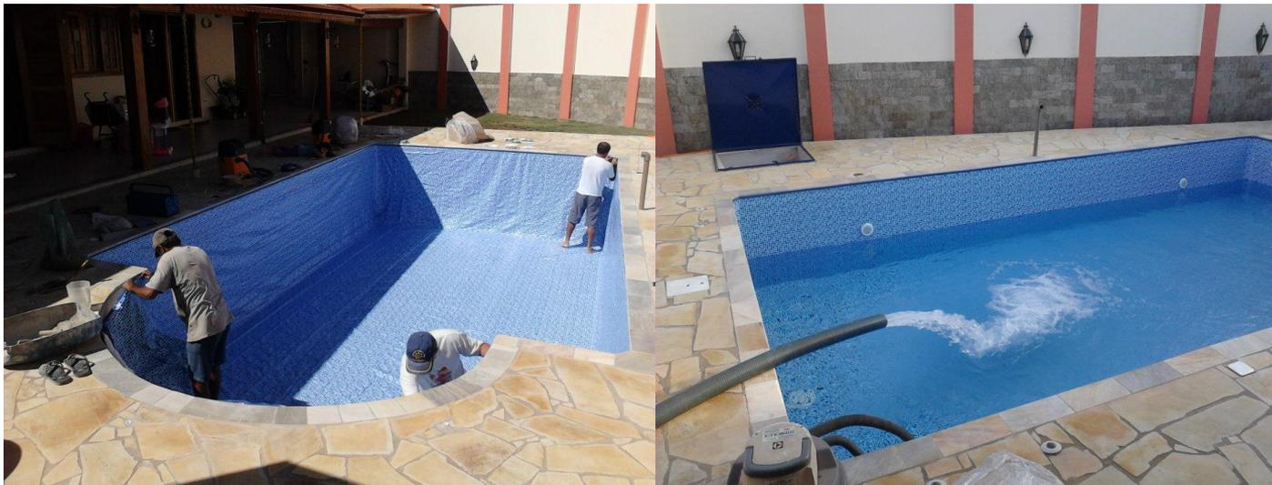
**Colocação do vinil com auxílio do aspirador para fixar o vinil na parede, e enchimento com caminhão pipa extremamente necessário que seja com o caminhão, pois para a fixação do vinil precisa ter pressão d'água. E Enfim você terá a sua piscina pronta para nadar!!!**
